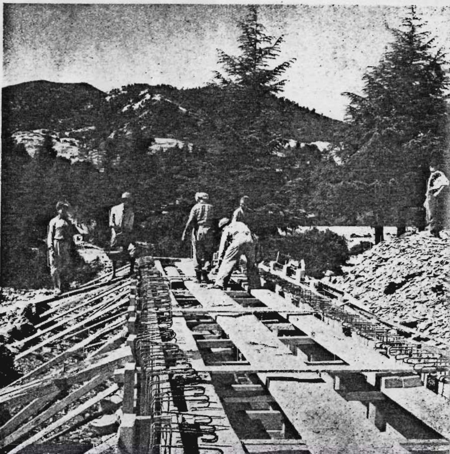
UNE ENTREPRISE PRIVÉE CONSTRUIT UN « DALOT » DE BÉTON SUR L'OUED KETAMA, ENTRE AIN ACHKAB ET SOUK-EL-TLETA.
